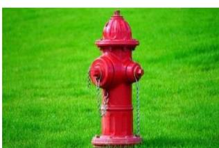
地上式消火栓の中には、使用しないときには自動弁で水を抜き、凍結による消火栓の破損を防止できる構造のものがあるようです(不凍式地上消火栓)。
